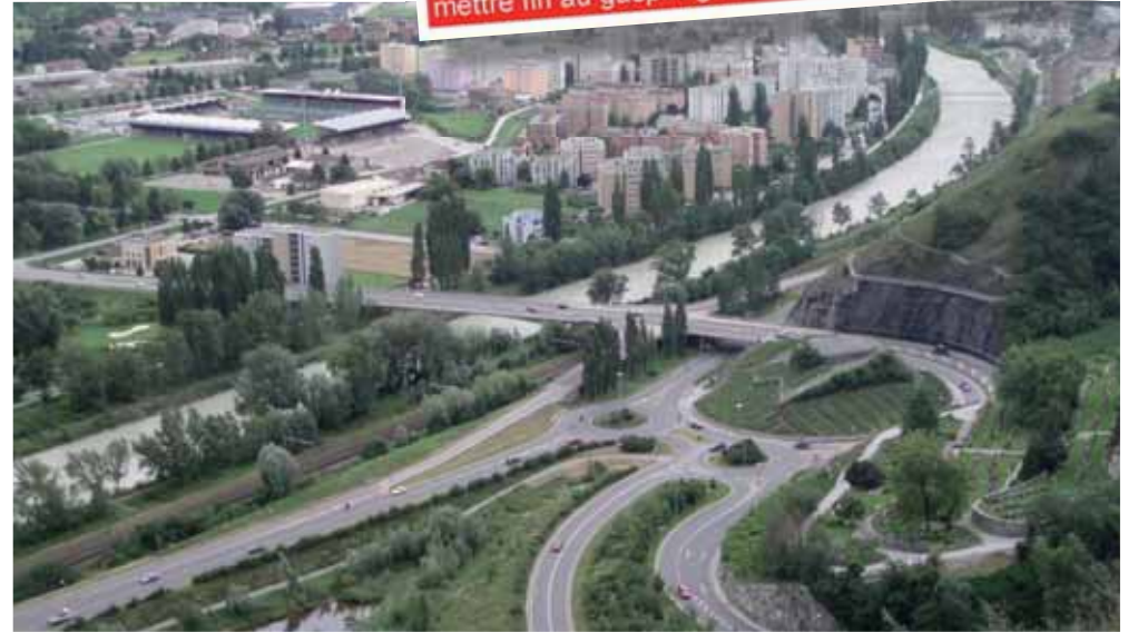
A Sion, les digues ont été renforcées et le lit du fleuve a été légèrement creusé. Pourquoi cette technique ne serait-elle pas possible ailleurs? dr
