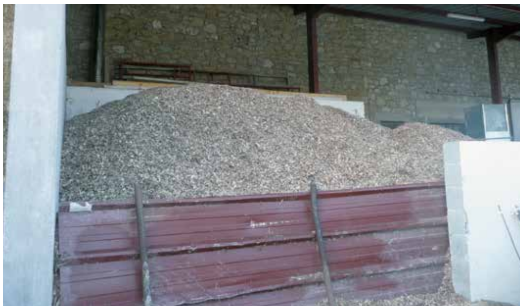
Hangar de stockage des plaquettes de bois
