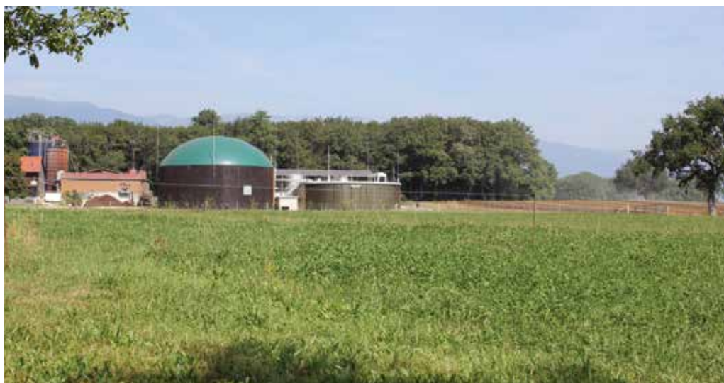
L'installation de biogaz avec le digesteur et le post-digesteur
