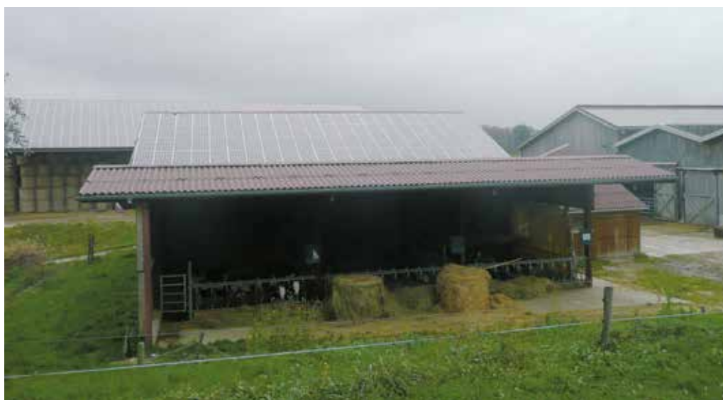
Une des trois toitures de la centrale solaire photovoltaïque
