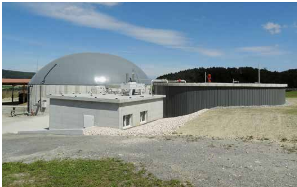
L'installation de biogaz agricole
