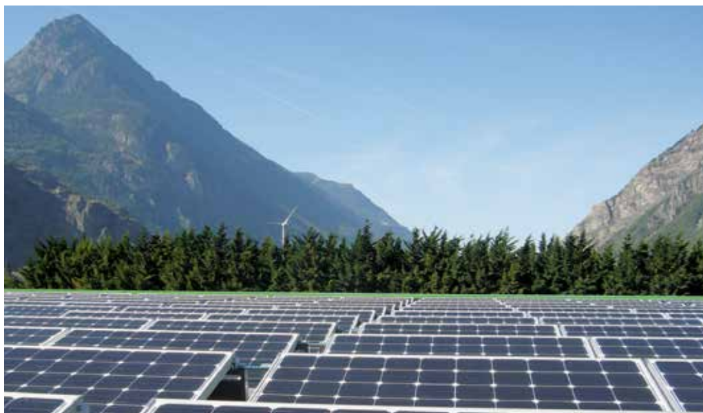
Les modules photovoltaïques posés sur une toiture plate
