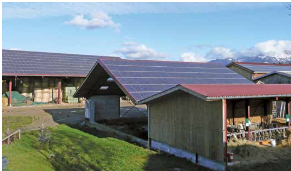
Vue d'ensemble de l'installation solaire photovoltaïque
