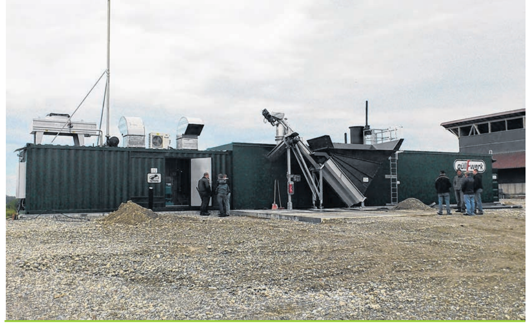
Des containers permettent le développement d'unités modulaires.
